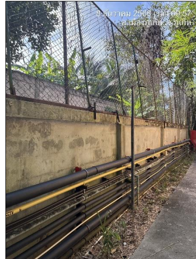
รูปภาพที่ 2.21 ระบบไฟฟ้าและไฟฟ้าสำรองบริเวณทางเดิน
